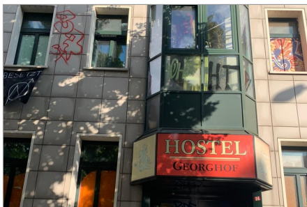
Das ehemalige Hostel Georghof in der Gürtelstraße.
